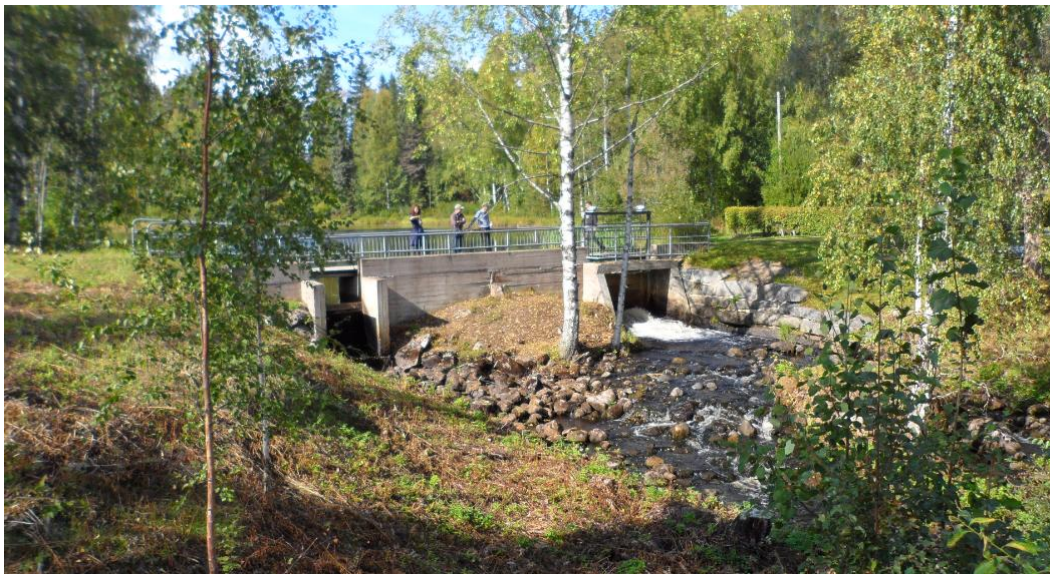
Kuva 2-10. Luonetjärven säännöstelypato on kaksiaukkoinen.
