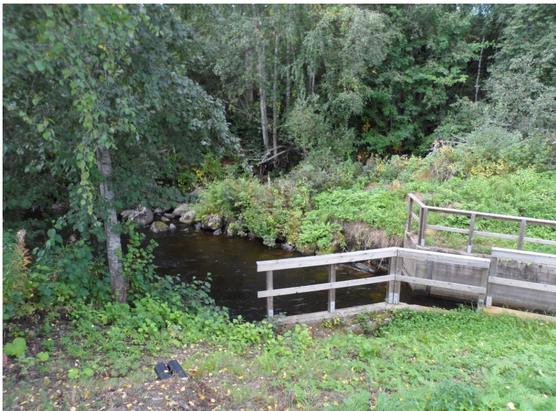
Kuva 2-18. Puuppolan voimalaitoksen alakanava. Taustalla näkyy puustoittunut vanha jokiuoma.
