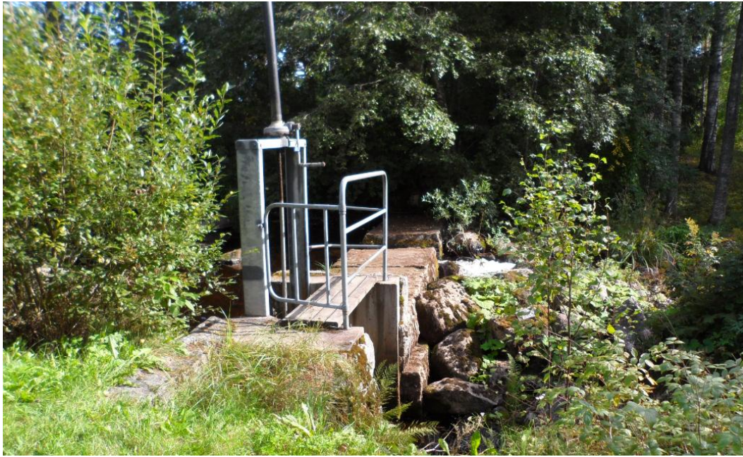
Kuva 2-14. Alamyyllylammen betonipato on tällä hetkellä osittainen nousueste.
